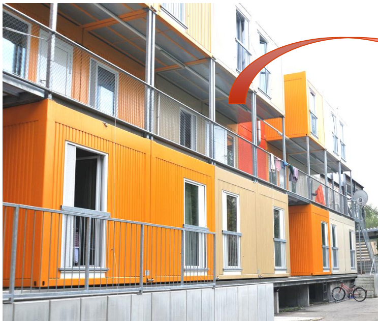
Containersiedlung für Asylantenheim
