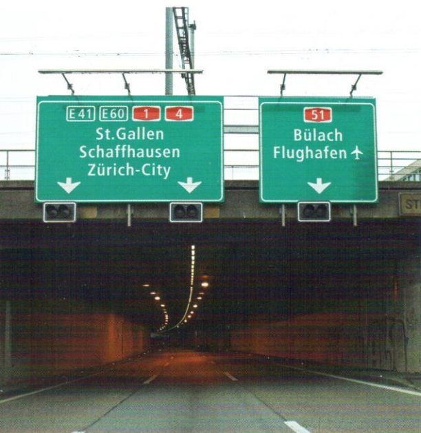
Portal des Stelzertunnels
