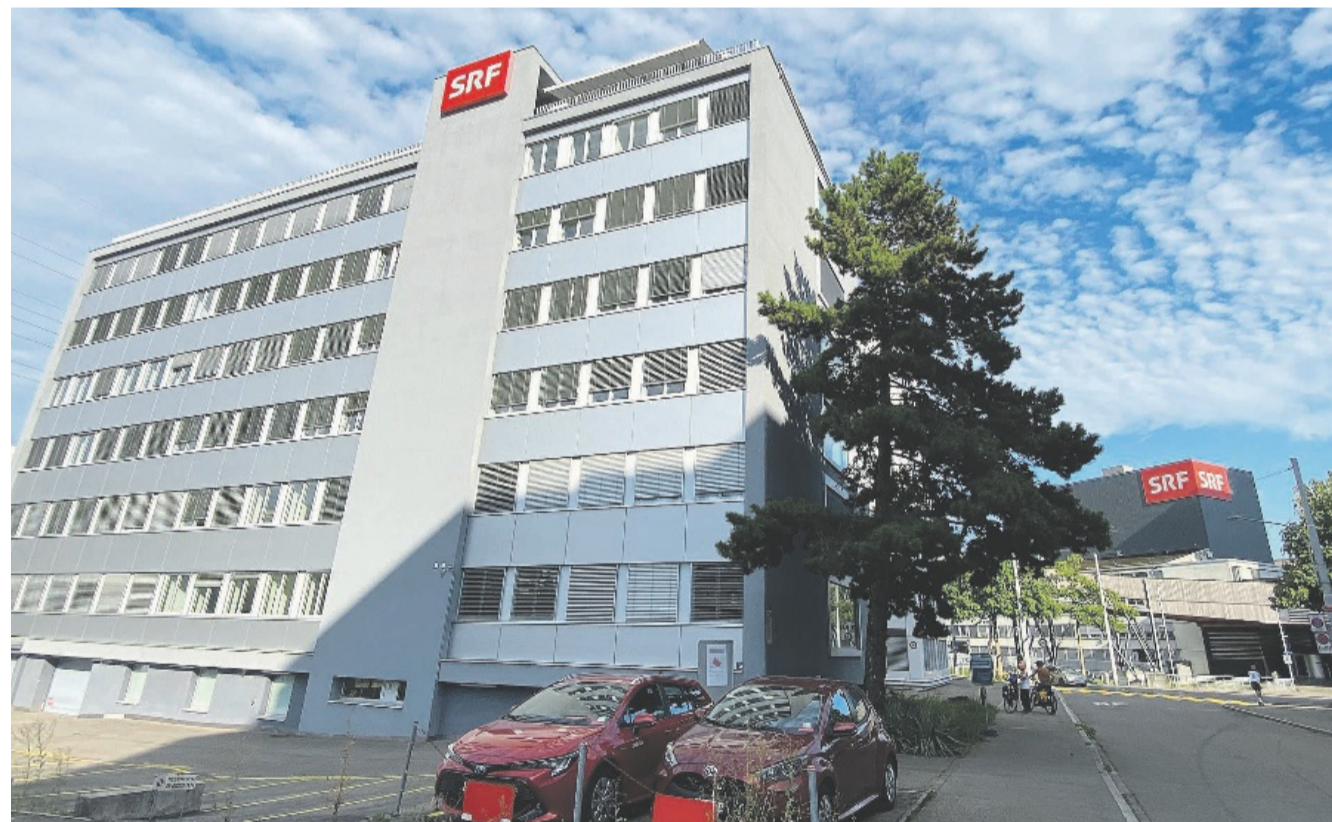
In diesen grauen Gebäuden an der Schärenmoosstrasse 115 und 117 sollen die Flüchtlinge bald übergangsmässig wohnen. Im Hintergrund die Studios und Büros von SRF an der Leutschenbachstrasse. BILD LORENZ STEINMANN
